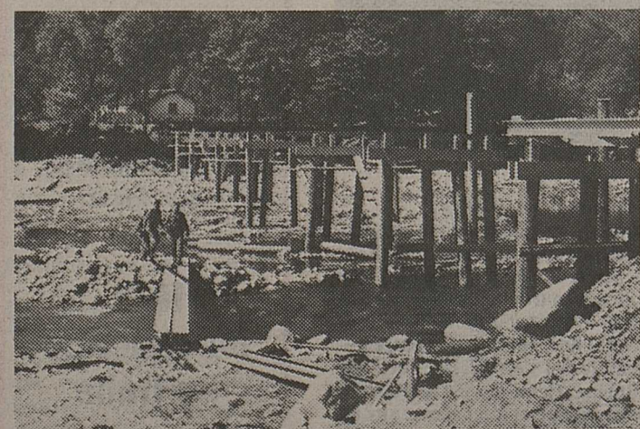
Construction d'un pont Din de 20 tonnes entre la route principale de la vallée Maggia et Aurigeno/Moghegno.
