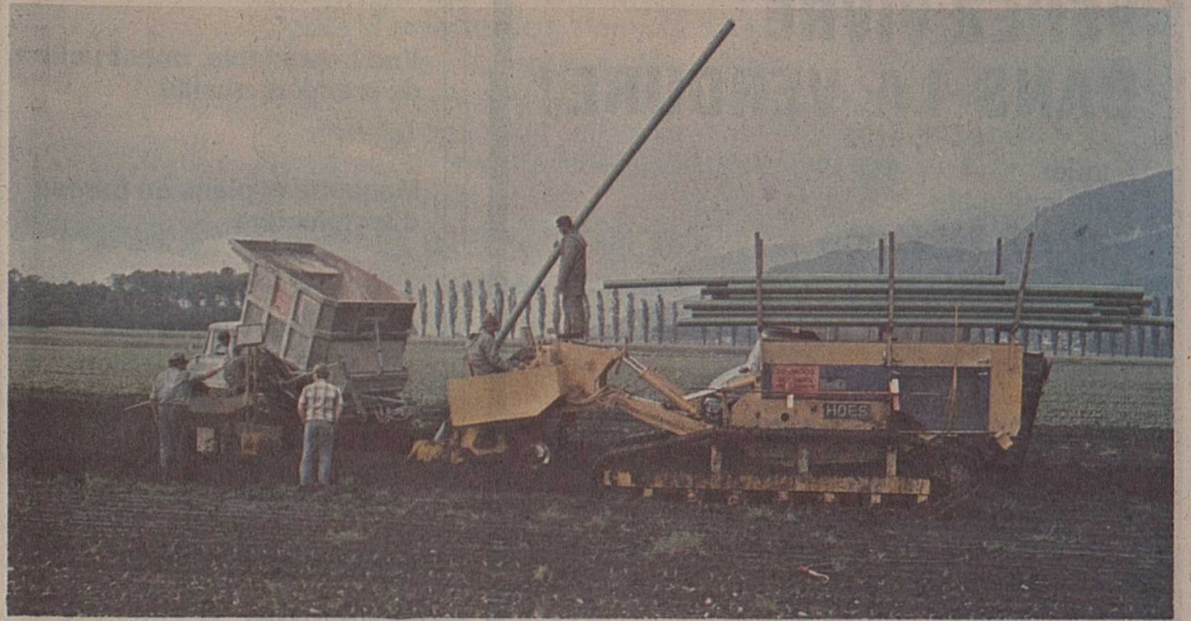
dent au fur et à mesure de l'avancement du scraper. Le gravier est transvasé dans la machine au moyen
