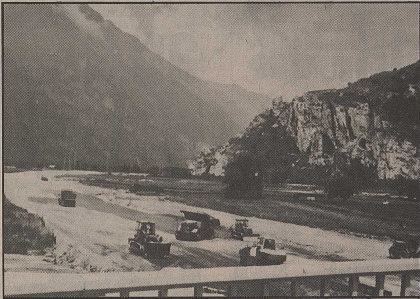
C'est un grouillement de machines qui effectuent une ronde bruyante et colorée qu'on aperçoit depuis le pont nouvellement construit. Au fond, à gauche, le Salentin; à droite, les rochers des Follateres, à l'endroit où le Rhône change de direction; l'autoroute l'imite.
