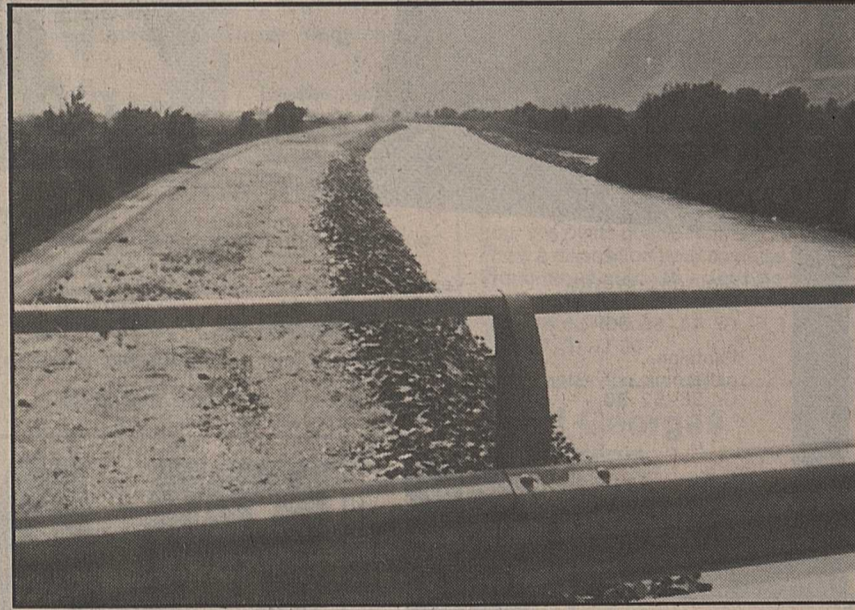
Entre Saillon et Mazembroz on a dû corriger le cours du Rhône et la digue rive gauche, sur 2500 mètres, sert de planie à l'autoroute. Notre photo est prise depuis le pont-route assurant la liaison entre la cantonale et Saillon.
