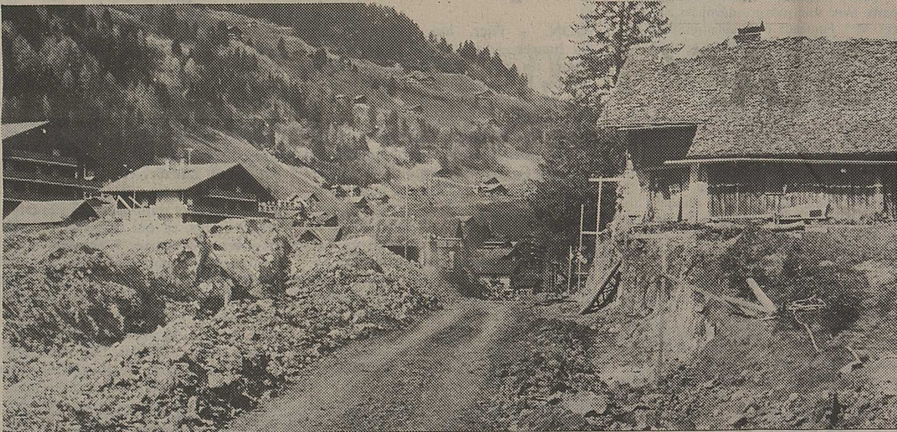
On remarque la percée qu'il a fallu faire dans le rocher à la hauteur du chalet de M me Céline Gex-Collet (à droite) pour permettre la jonction de ce nouveau tronçon de la route de ceinture qui rendra l'accès au Grand-Paradis plus facile.
