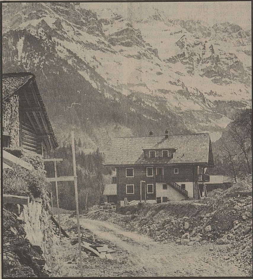
A gauche, le chalet de M me Céline Gex-Collet qui est aujourd'hui en surplomb sur la nouvelle route creusée en partie dans le rocher en direction des « Ravines ». Au fond le massif des Dents-Blanches.
