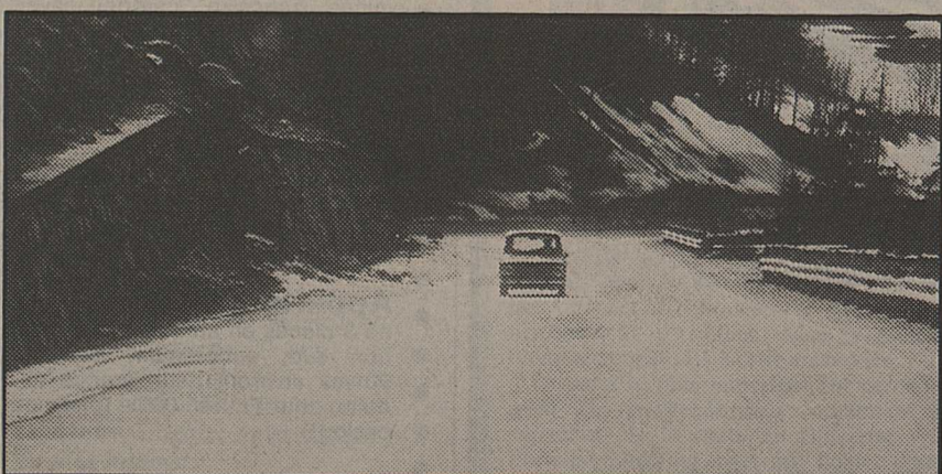
Les nouveaux tronçons, datant d'à peine quelques années, n'ont guère mieux résisté à l'hiver que l'ancienne route : ce qui laisse douter de leur bonne facture initiale.
