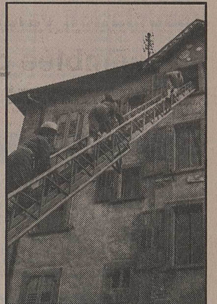
Grâce à l'échelle, on peut intervenir dans les combles.
