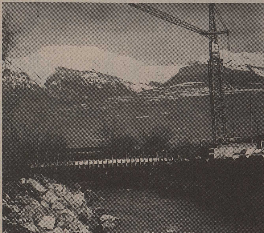
L'état actuel des travaux.
