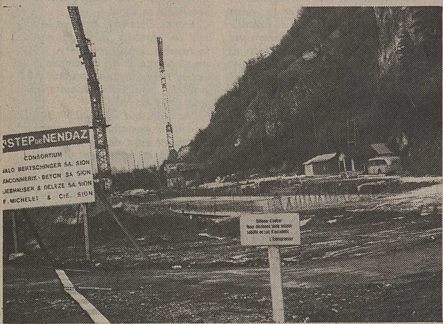
Une vue du chantier de la construction de la Step sous Bieudron.
