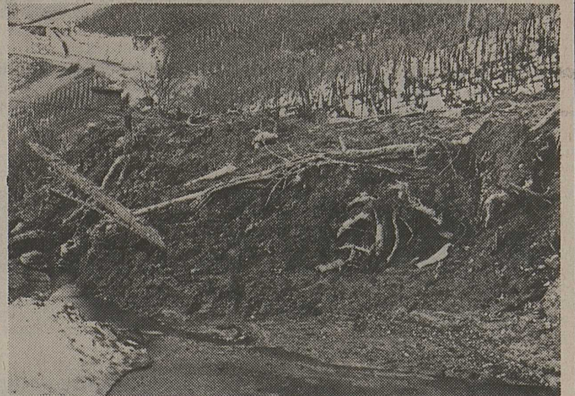
La route agricole, à l'ouest du village d'Ollon, coupée par une coulée de boue.
