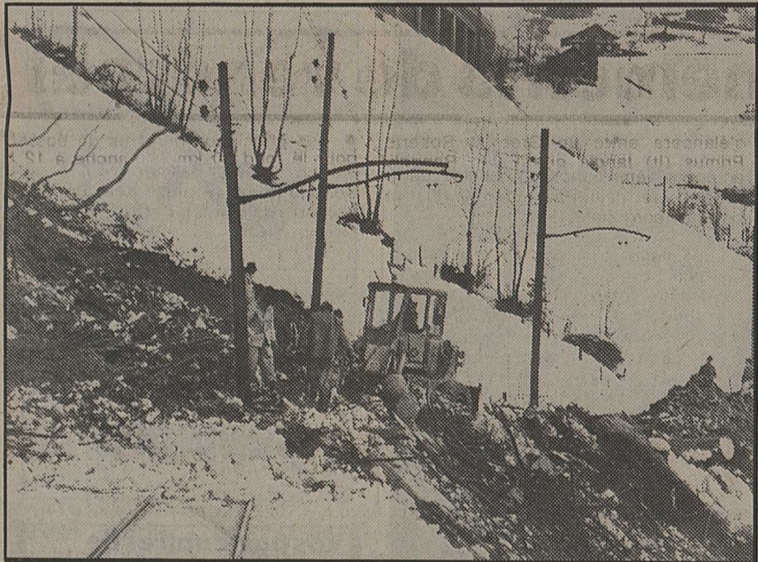
Vue du côté aval, la voie de l'AOMC recouverte de divers matériaux qu'un trax est occupé à dégager. En haut, la route de Champéry dont une partie de la chaussée aval est posée sur des piliers de béton. Au fond les premiers chalets de Val-d'Illiez.
