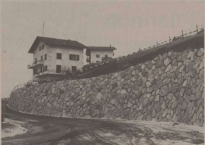
L'un des deux murs
