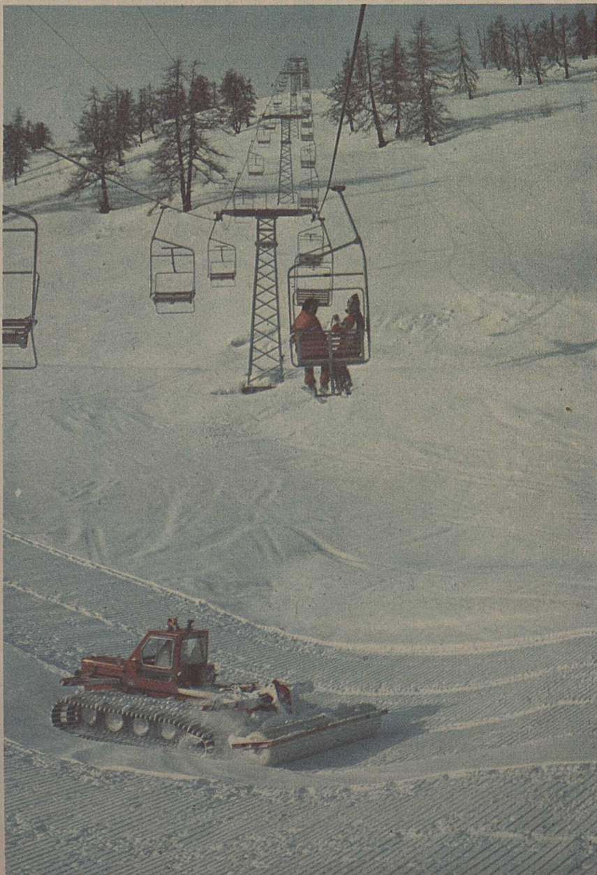
Un télésiège, remontée mécanique principale, et un téléski, un peu plus haut, desservent la station de Vichères-Bavon. La première installation, que l'on voit ici, mène des hauts de Vichères au domaine skiable de Bavon, dont les pistes sont entretenues par un rattrac.
