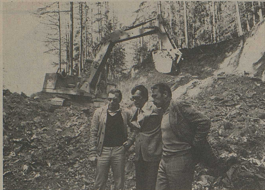
MM. Francis Barras, ingénieur, Hubert Bonvin, conseiller communal et Marius Mittaz, entrepreneur visitent le chantier.
