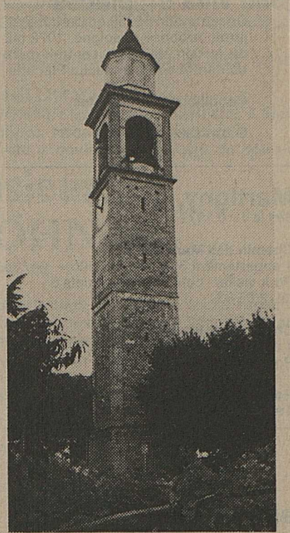
Au pied de la treille, la tour du clocher sur laquelle, l'an prochain, on hissera le taureau.
