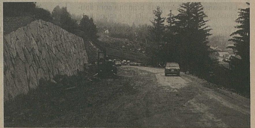
Un mur de soutènement construit dans le cadre de l'aménagement de la route qui conduit de Saint-Nicolas à Graechen.
