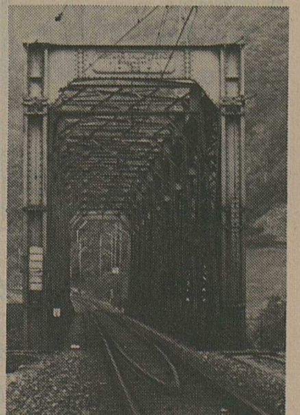
La ligne du BLS traversant le Rhône à Brigue.
