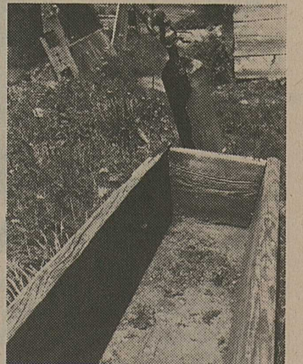
L'une des nombreuses fontaines « à sec » depuis la construction de la galerie.
