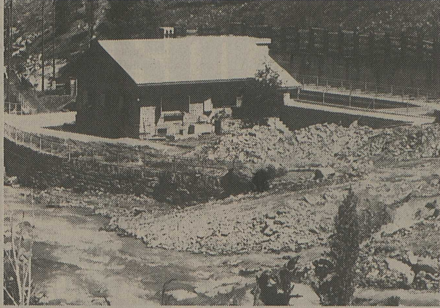
Une vue des matériaux qui se sont échoués jusque devant la porte de la maison du garde de la prise d'eau.
