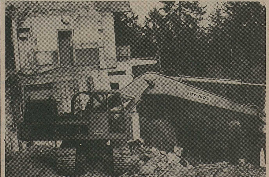
On termine les travaux de démolition
