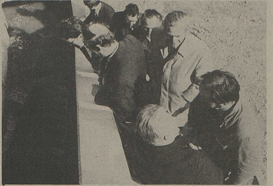
Autorités et responsables du chantier et de l'usine ont assisté à la mise en eau.
