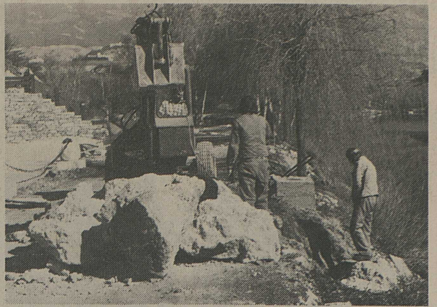
A l'aide d'une grue, des blocs de pierre sont mis en place pour garantir la stabilité de la route.
