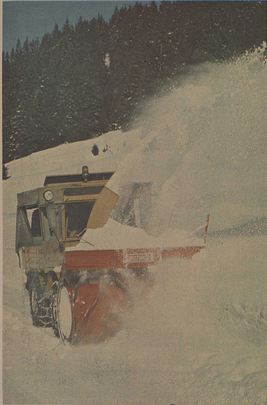
Au col de Morgins, la fraiseuse sur l'Unimog procède à l'élargissement de la chaussée. Photo NF
