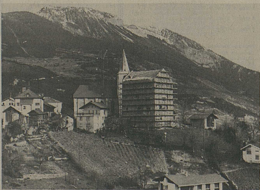
Le château de Venthône est encore en réparation.
