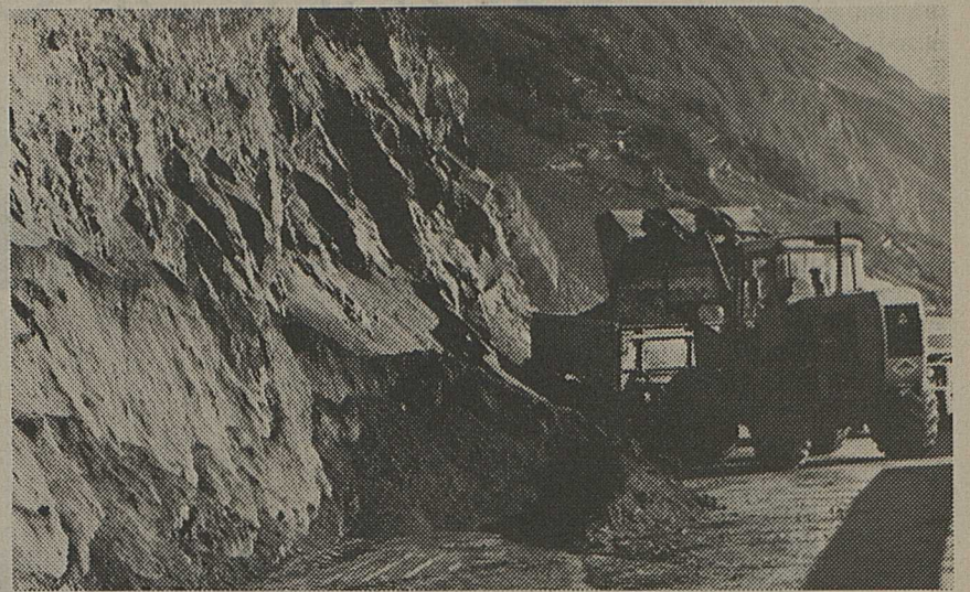
Un trax charge terre et tout-venant qui sont évacués en plaine. Tout en haut, à gauche, une partie de la barrière de protection.
