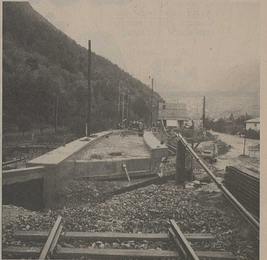
Le nouveau pont est en place ; reste à y installer les voies.
