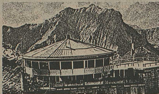
Une citerne MWB de 100000 l assure l'alimentation en eau de la station terminale «Piz Gloria» du téléphérique du Schilthorn. Des citernes à eau de 2000 à 300000 l construites par notre usine sont installées partout en Suisse.
