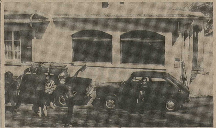
L'établissement dont la véranda, au premier plan, avait particulièrement souffert de la furie blanche.
