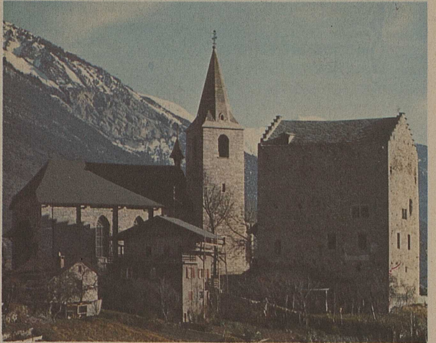
La tour de Venthône, joyau de l'architecture romane, aura une destinée partagée entre l'art et la gastronomie. Photo NF
