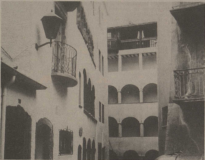
Une vue du bâtiment aux arcades.
