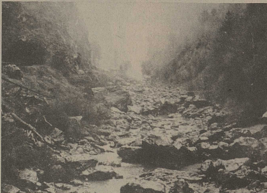
On distingue en haut à gauche l'entrée du tunnel.
