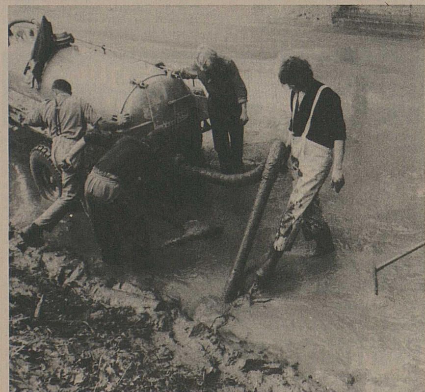
Ci-dessus l'évacuation de la boue. Ci-contre, une des nombreuses routes obstruées par un conglomérat de boue, de pierres et d'autres éléments amenés par l'eau.
