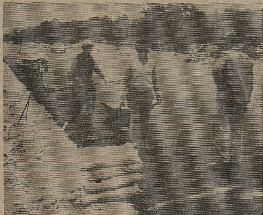
Kantoniere beschäftigen sich beim Plazieren der Leitplanken. Diese Leitplanken werden jedoch nur vor den Hochspannungsmasten und an äusserst gefährlichen Stellen erstellt.
