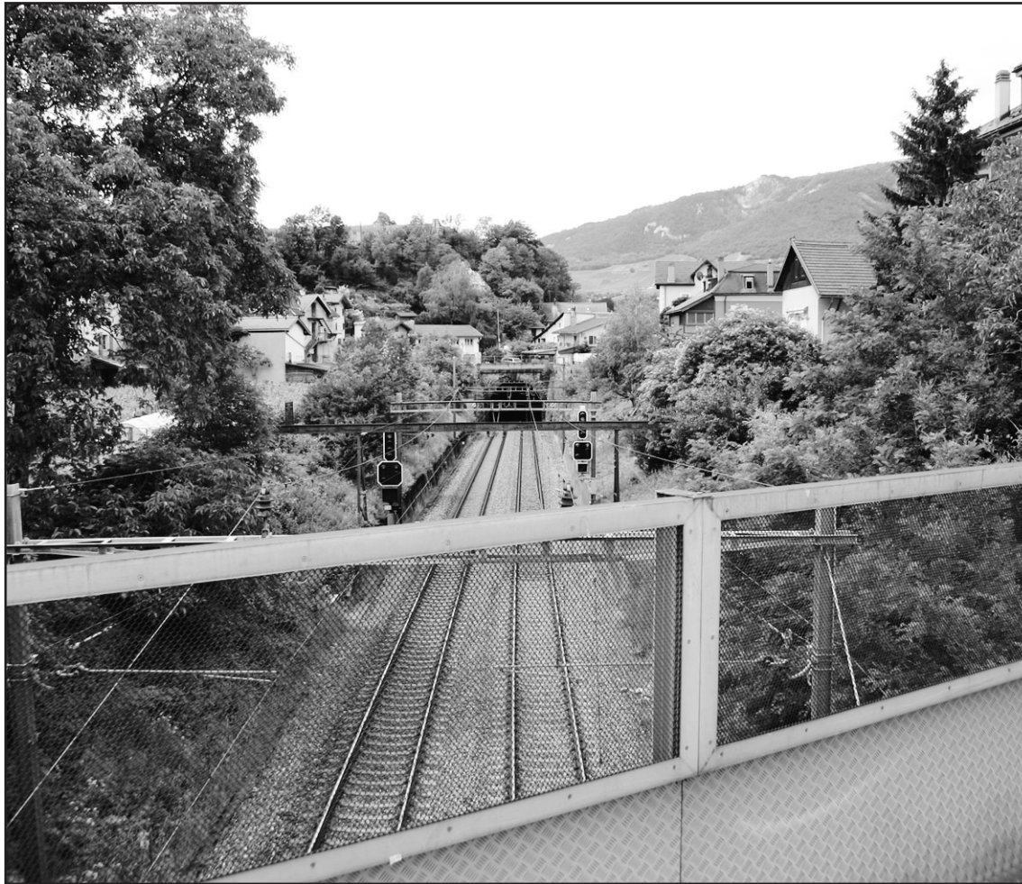
La sortie est du tunnel de Gobet vu du pont routier de Glarey. Celui-ci sera démolé et remplacé par une passerelle située à égale distance du tunnel et du pont actuels. LE NOUVELLISTE
