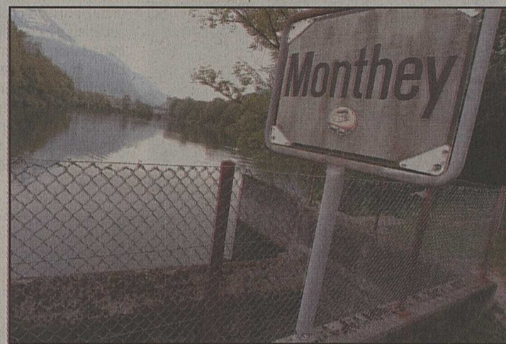
Troisième site à assainir: le lieu-dit L'étang avec des travaux qui débuteront avant la fin de l'année 2007. BITTEL
