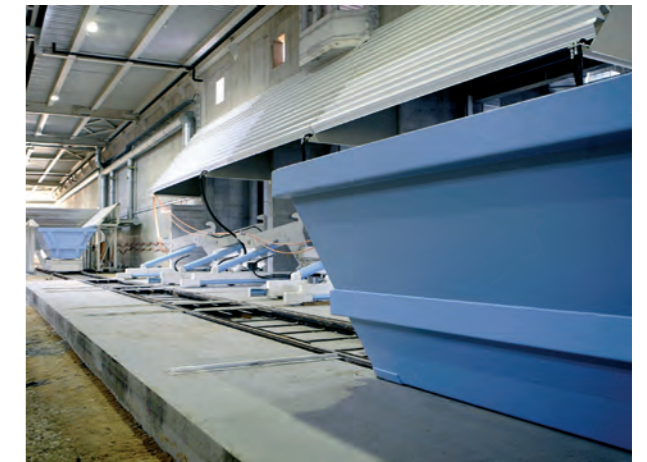
Les wagonnets de 20 mètres cubes de volume sont déjà installés. Ils transporteront les déchets excavés par le grappin et les basculeront par un système hydraulique dans les bunkers de réception.
