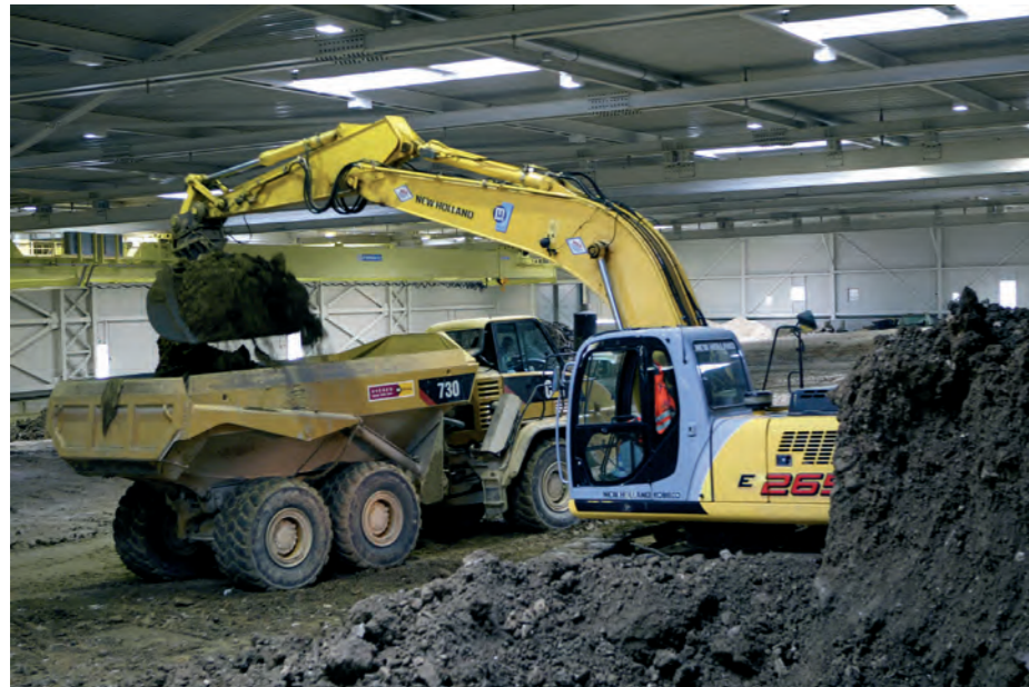
De grandes machines de chantier enlèvent couche par couche le couvercle supérieur.
