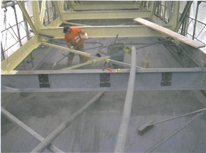
Fig. 4: Travaux de sablage.
