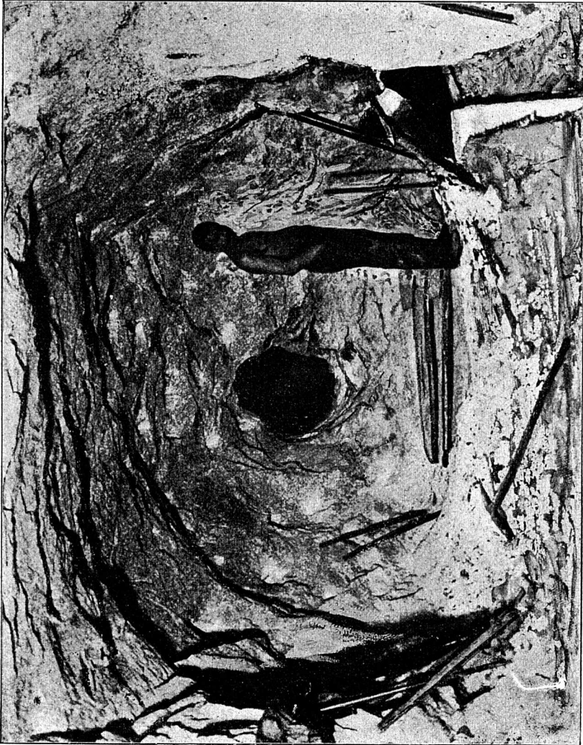
Jonction de deux amorces dans la galerie de faite (E.)
