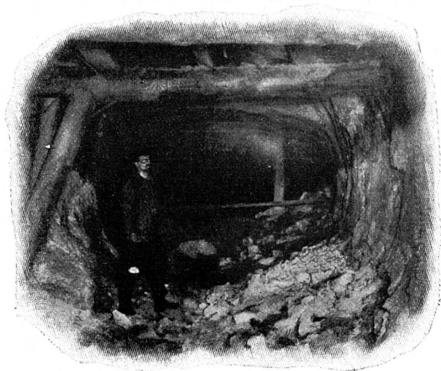
L'abatis de la dernière perforation mécanique. Photographie prise dans la soirée du 24 février 1905, par 43° C., au fond de la galerie I, quelques mètres en deçà de la brèche terminale. (Photo Bacilieri, ing.).
