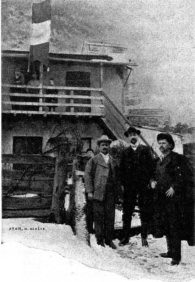
MM. Betassa, assistant, Bacilieri, ingénieur, et Ribotto, chef d'équipe, qui étaient à l'avancement dans la nuit du 23/24 février 1905.
