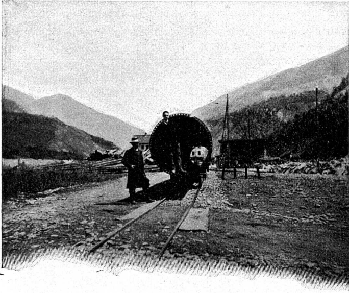
Tuyau en tôle d'acier pour la conduite en charge de l'eau motrice.
