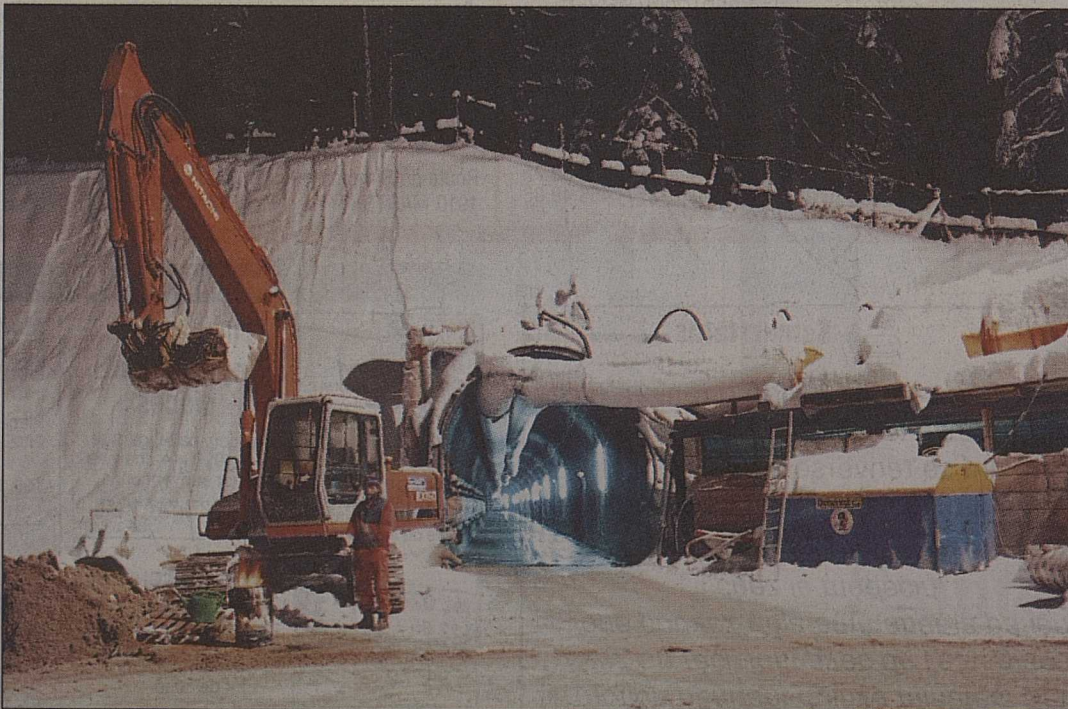
Vue de l'entrée de la galerie du chantier de Dzerjonna où les invités ont pu visionner l'ultime percée.
