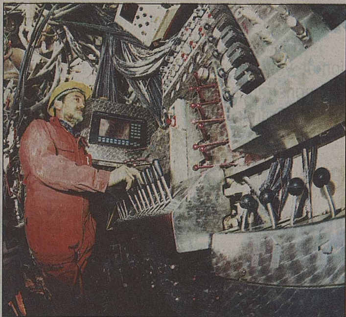
Pilote aux commandes du dernier tunnelier en service.
