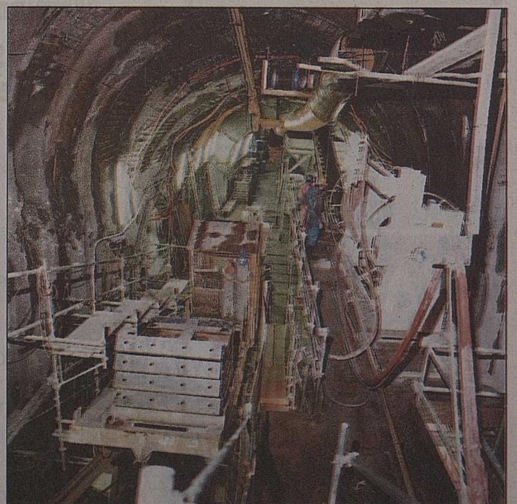
Vue de la gare de départ de la navette.
