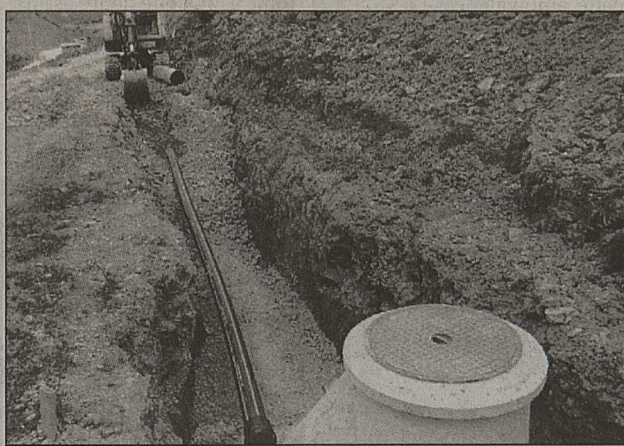
Les travaux pour les collecteurs durent depuis quelques années déjà.
