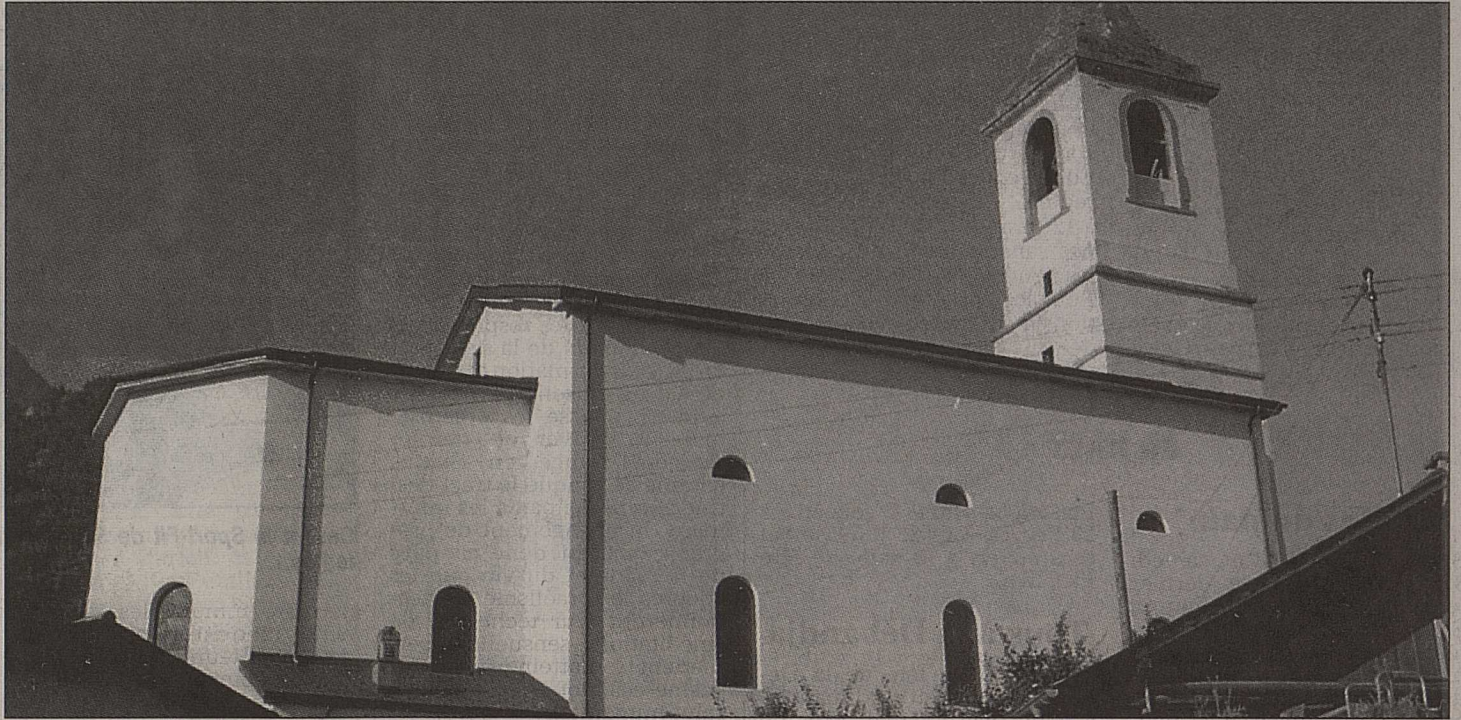
L'église de Saxon n'a pas été rénovée depuis les années cinquante. A l'extérieur et à l'intérieur, l'ensemble des travaux coûtera près d'un million de francs.
