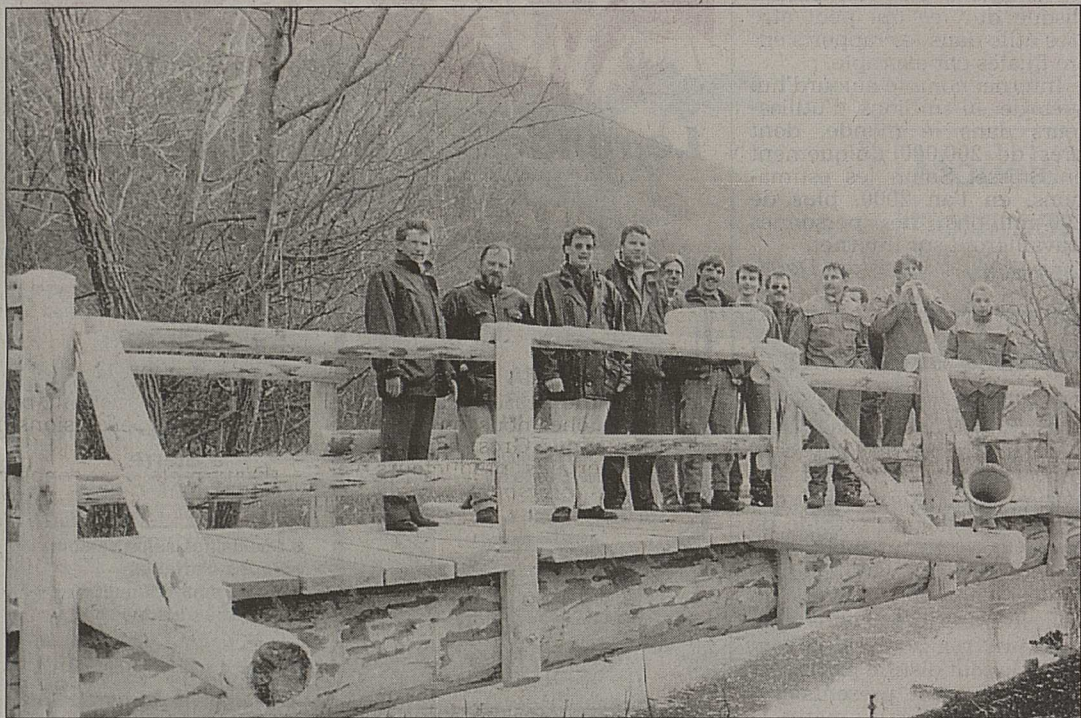
Les ouvriers de la protection civile, sur le nouveau pont qu'ils ont construit en quelques jours.
