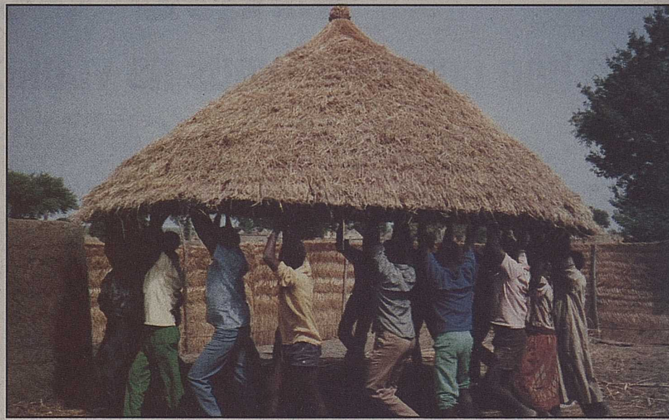
Construction d'une case en Afrique.
