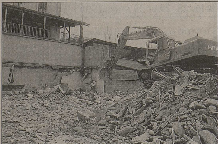
L'immeuble de la rue de Pratifori en pleine démolition.
