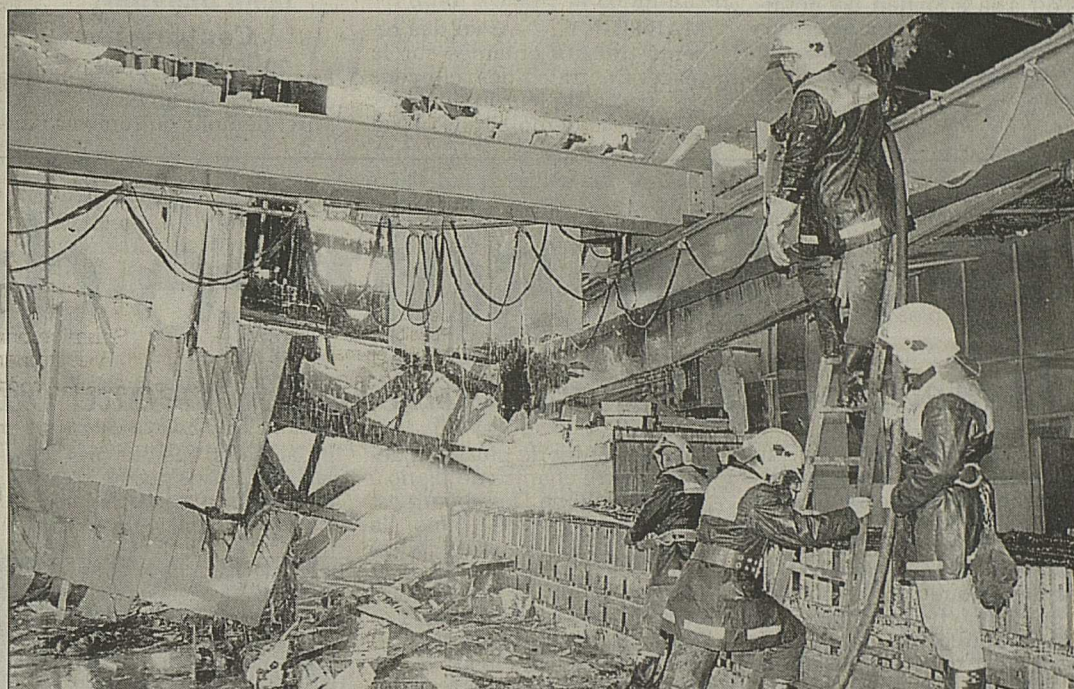
Une partie de la toiture s'est effondrée.
