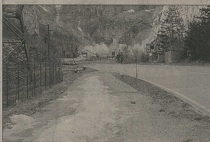
A Gondo, le poste de la police cantonale est compromis.
