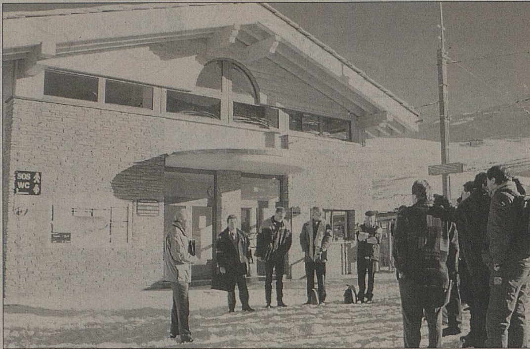
La nouvelle gare du Gornergratbahn, à Riffelberg.
