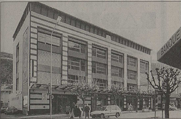
Le nouveau bâtiment de la BCV Martigny n'a plus grand-chose en commun avec celui construit en 1947 par l'architecte Perraudin.
