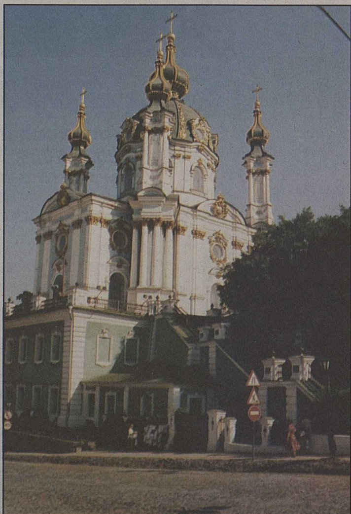
Aérée et gracieuse, l'église de Saint-André a été construite sur la colline de Vieux Kiev en 1749. Elle est l'œuvre du célèbre architecte italien Rastrelli.
