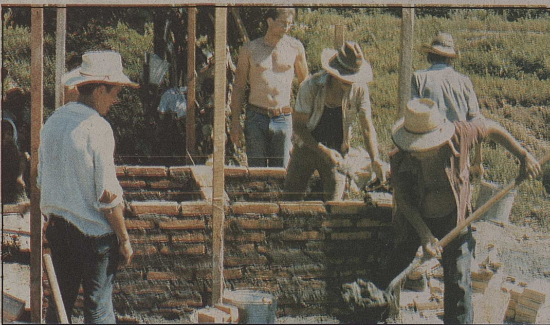
Honduras: constructions de latrines.
