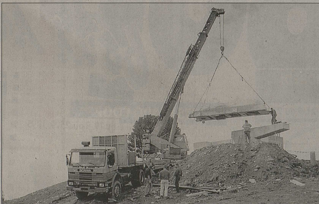
Déchargement de la station motrice à Trabanta. Une pièce de 23 tonnes, transportée au sommet à bord d'un semi-remorque tout terrain et placée sur son support au moyen d'une grue géante.
