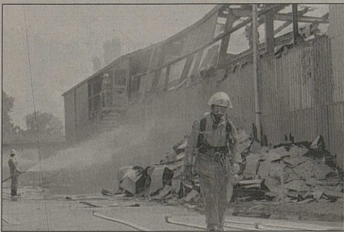
Un bâtiment abritant entrepôts et bureaux a été complètement détruit à Dietikon (ZH).
