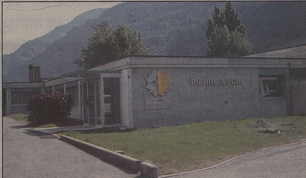
La partie centrale du home Pierre-à-Voir fraîchement restauré.
