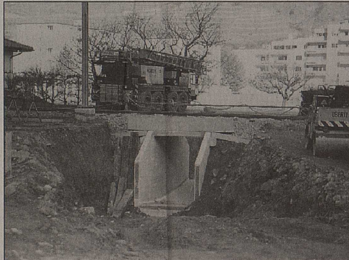
La percée du passage inférieur servant à relier la Fondation Pierre-Gianadda à l'amphithéâtre menée à bien en une douzaine d'heures... un 1er avril.
