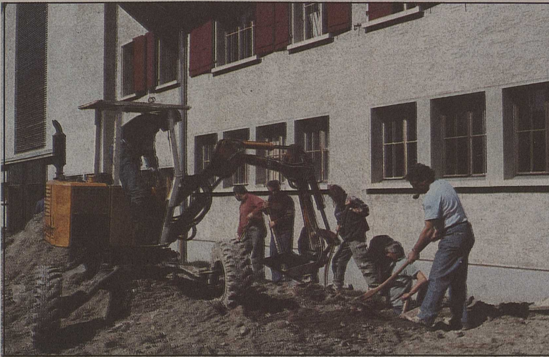
Les rénovations permettent l'occupation de chômeurs en fin de droits. La tranchée pour la conduite de gaz a été creusée en un temps record.
