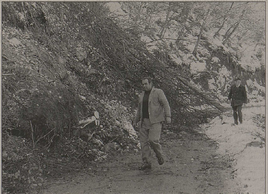
On ne passe plus. Des centaines d'arbres et des tonnes de boue obstruent la route cantonale reliant Saxon à Tovassière. nt
